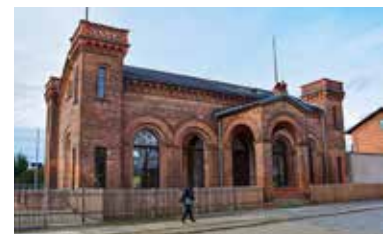
Bahnhofsgebäude in Halbe Foto: vbb
